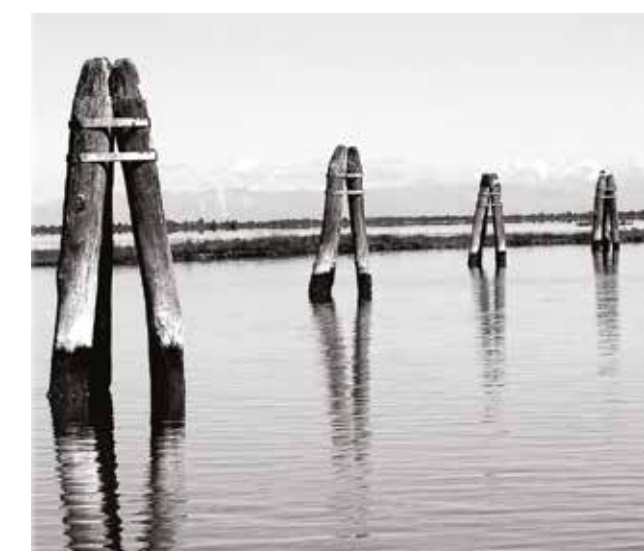
Bricole della laguna di Venezia Dolphins from the Venetian lagoon
